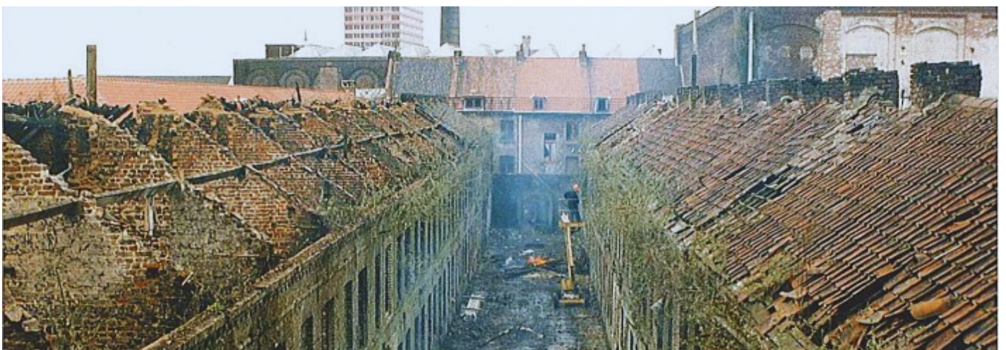
Courrée - Logement ouvrier
