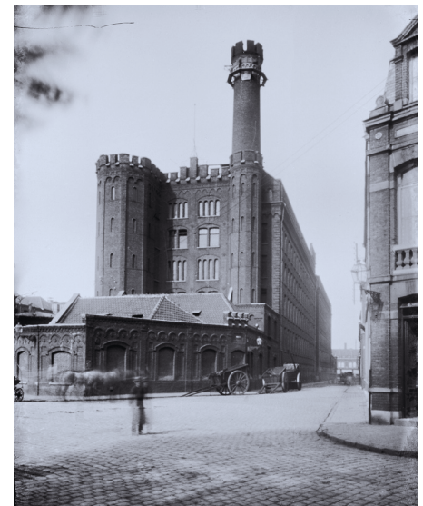
Usine Motte-Bossut réaffectée en bâtiment d'archives
